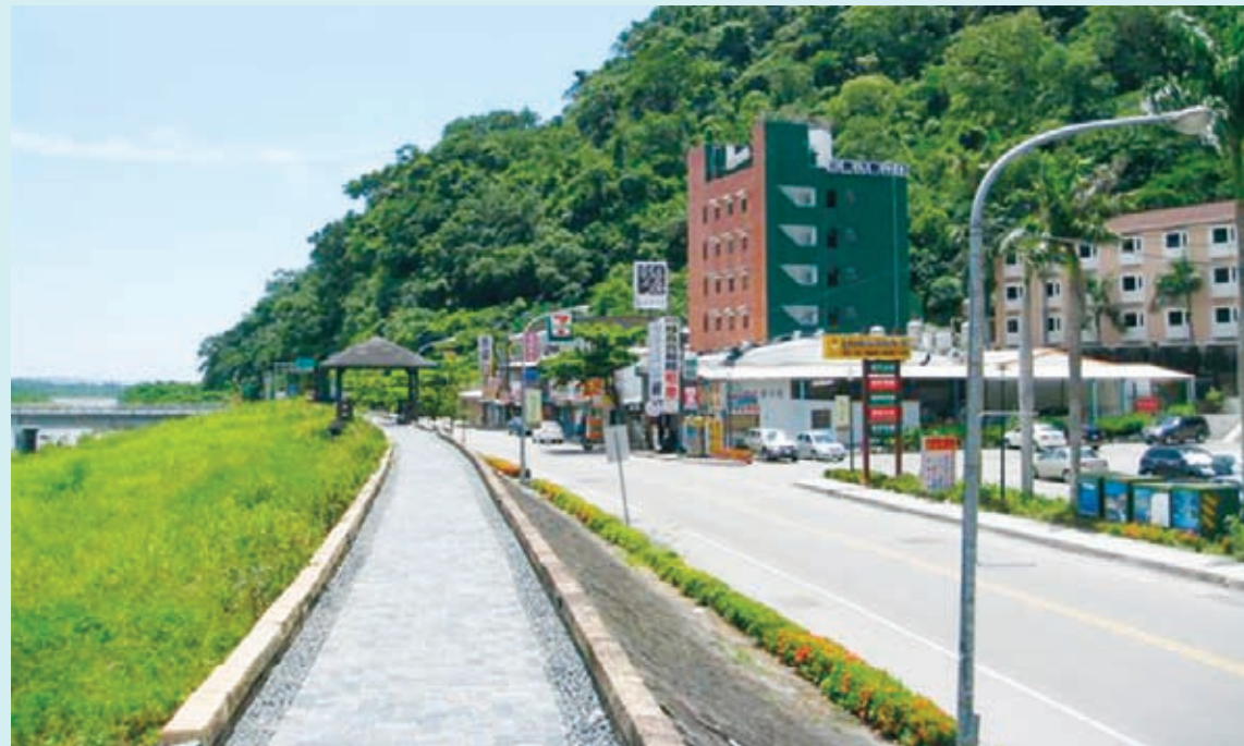
遠離河邊卅餘公尺的金帥飯店原貌
